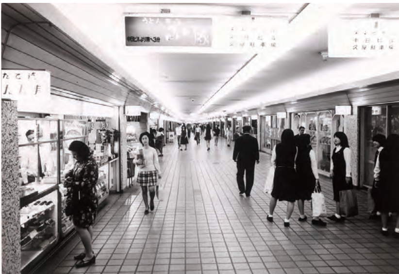
昭和44年当時の栄東地下街(現・森の地下街南二番街)
